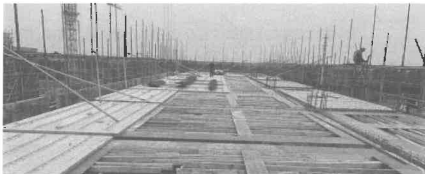
图2叠合板支撑架+木方
