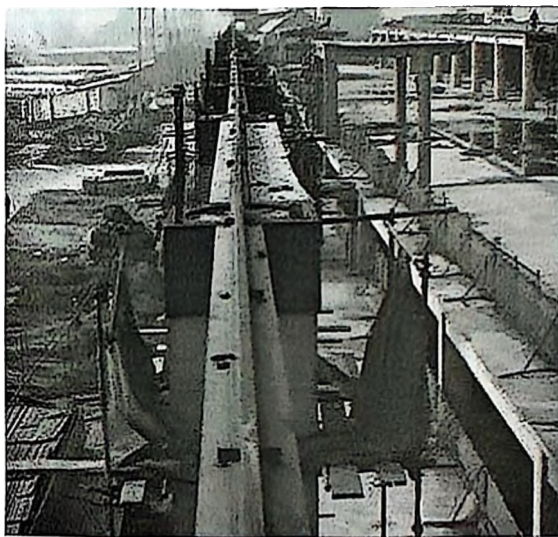
图7 滑移轨道示意图
