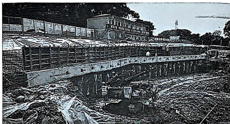
图2 钻孔灌注桩、冠梁施工照片
