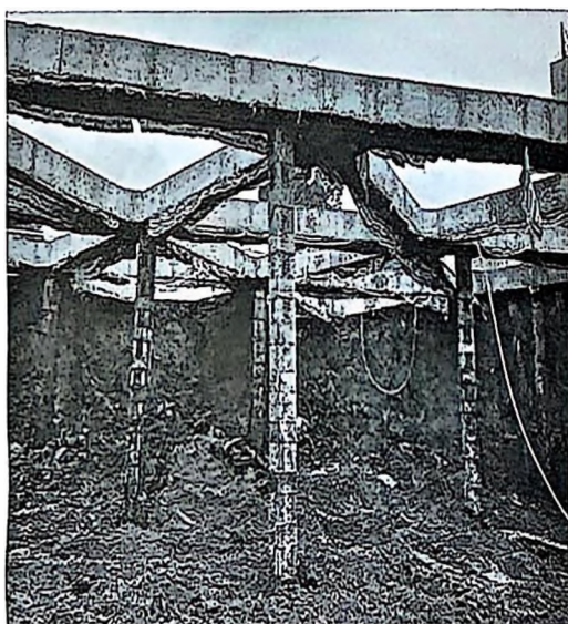
图3 型钢混凝土组合支撑结构施工照片
