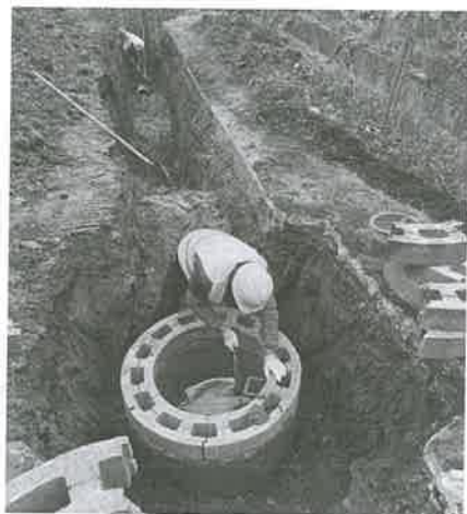
图1: 现场施工的预制砼模块井
