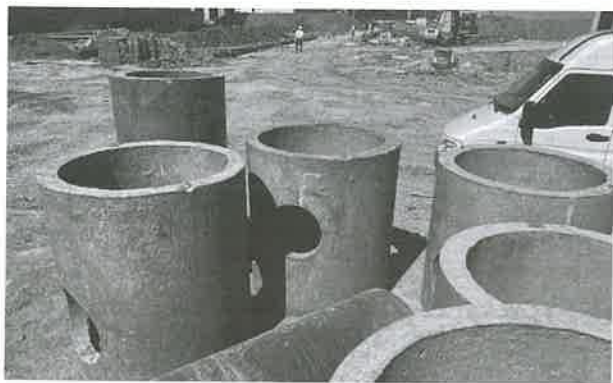
图2: 装配式预制砼(节) (圆形检查井)
