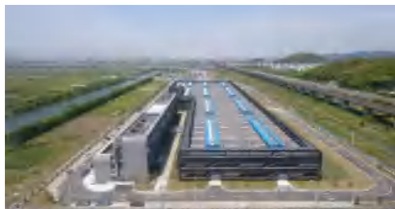
宁波轨道交通4号线慈城停车场
