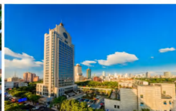
宁波检验检疫大楼(鲁班奖)
