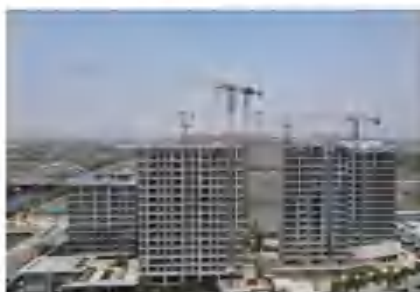
在建项目天润建筑慈白沙 I202004#地块
